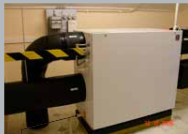
Vesilukko, korkeus on oltava tarpeeksi suuri (padotuskorkeus).
